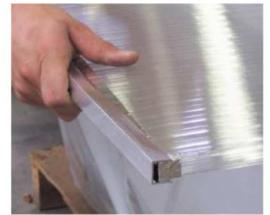
Die untere Stirnseite wird mit dem Aluminium-Tropfkantenprofil verschlossen. Bei Bedarf kann die untere Stirnseite vorher noch zusätzlich mit einem atmungsaktiven „Anti-dust“-Klebeband abgeklebt werden. Dies kann ggfs. das Eindringen von Staub in die Kammern verhindern, jedoch in Einzelfällen zu erhöhter Kondenswasserbildung in den Kammern führen!
